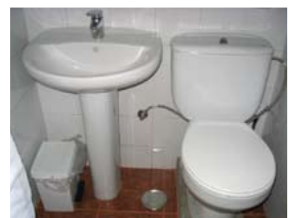
Inodoro sin espacio para la transferencia.
