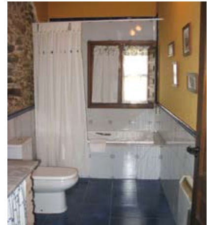
La bañera carece de barras que ayuden a la transferencia.
